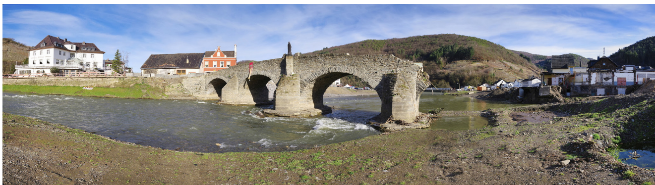
Abb. 1: Durch die Flutkatastrophe zerstörte Nepomukbrücke in Rech (2022)
