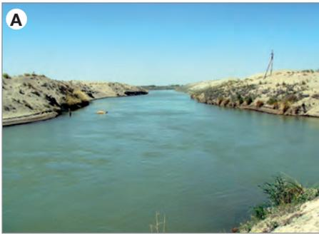
Unbefestigter Bewässerungskanal (sandiger Untergrund) zum Ferntransport größerer Wassermassen
